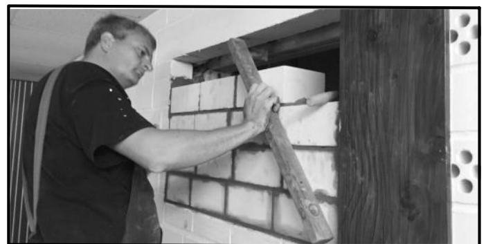
Matthias Jelinek prüft mit der Wasserwaage.
